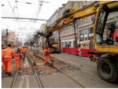
Foto: Dirk Knofe Großbaustelle Karli: Auf die Anlieger kommen Straßenausbaubeiträge zu.
